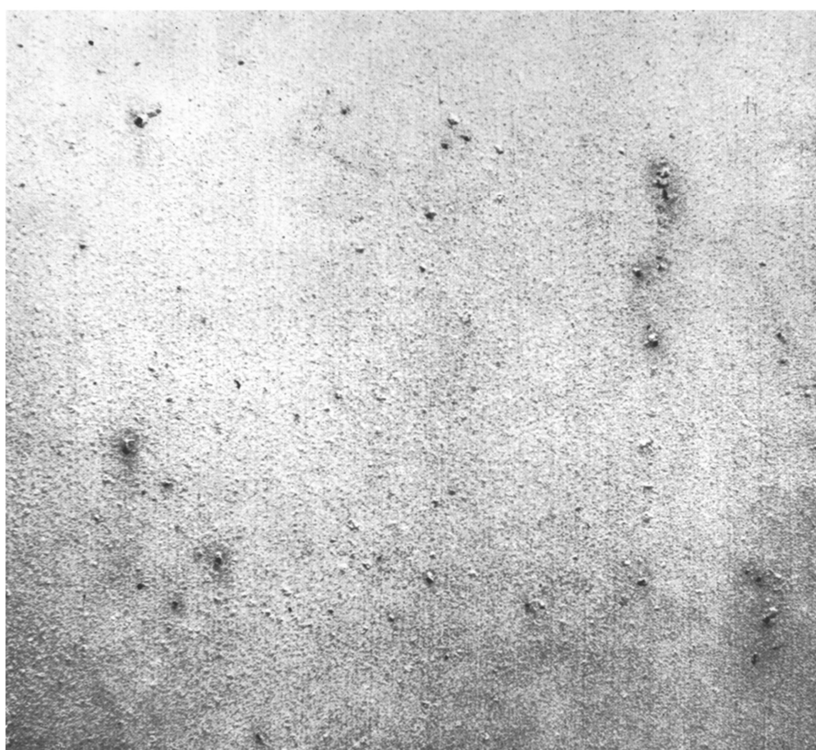
Рисунок 10 — Коррозия металла балл K2 (или Ri2 )
